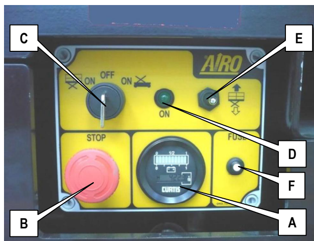
5-3: Quadro comandi a terra
