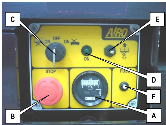
5-3: Quadro comandi a terra
