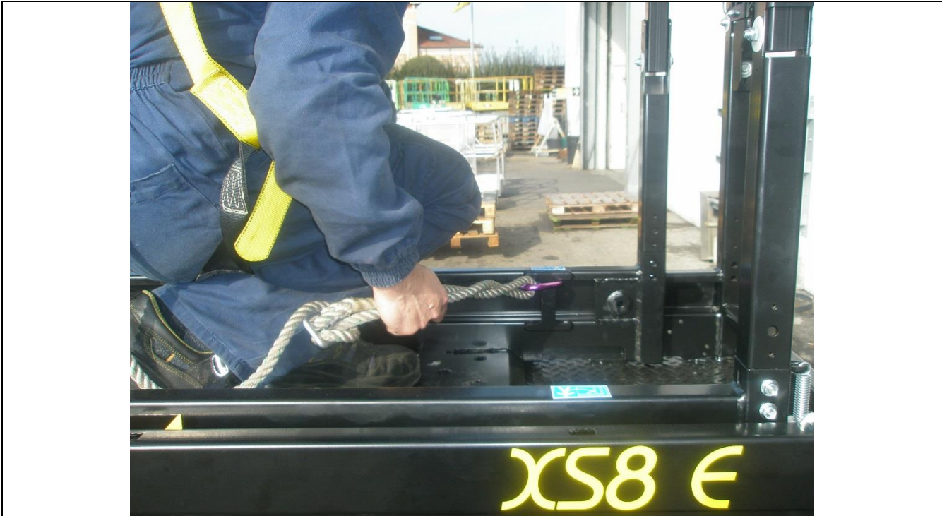
3-1: A hevederek rögzítése
